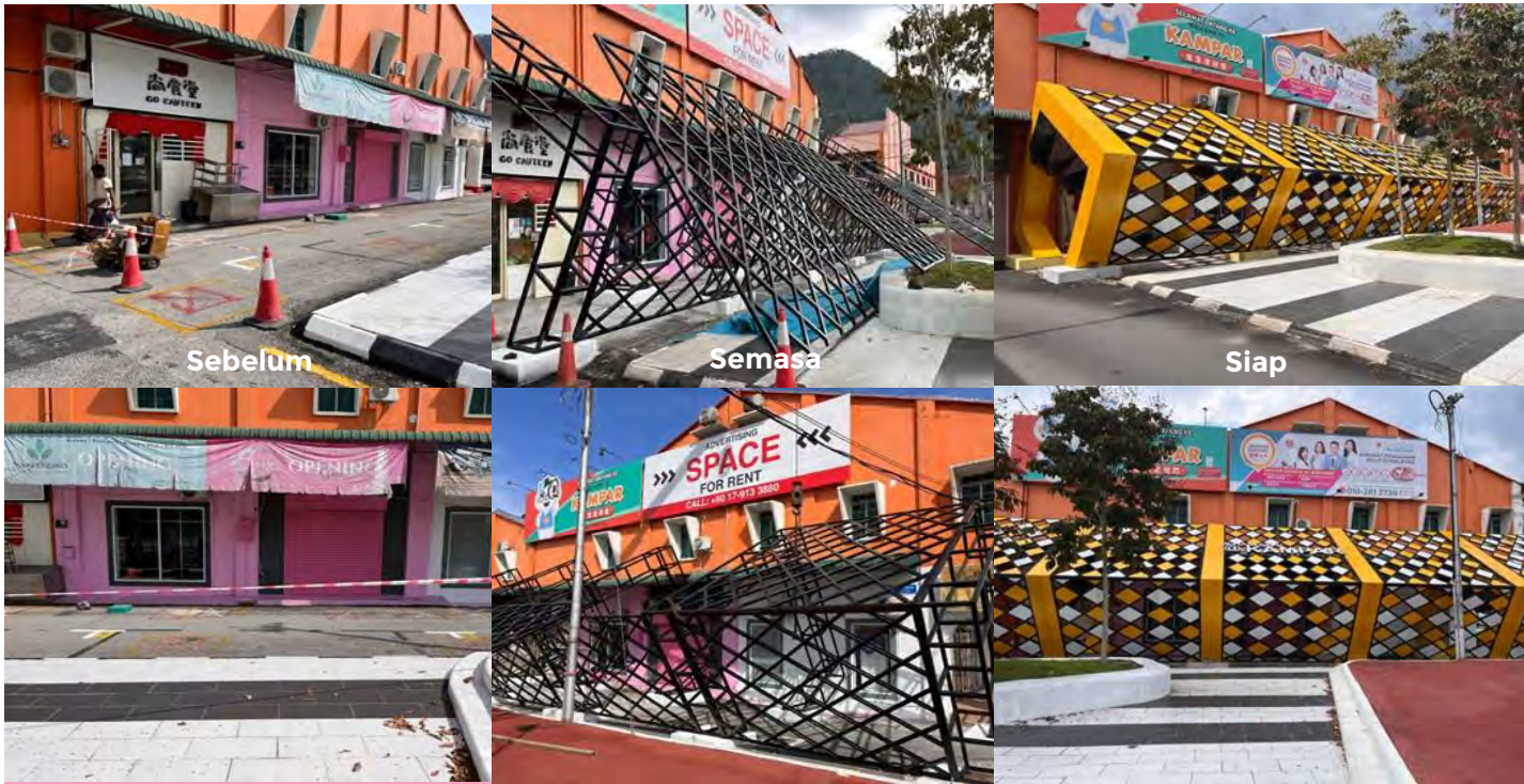
Penyediaan Pintu Gerbang ('Arch') Di Tapak Ilham Seni @ Kampar Peruntukan : PELANCONGAN Kontraktor : Mega AMP Enterprise
